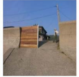
黒崎漁港防波堤改修工事決定
