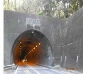
畝刈トンネル改良事業で照明問題を解決しました。
